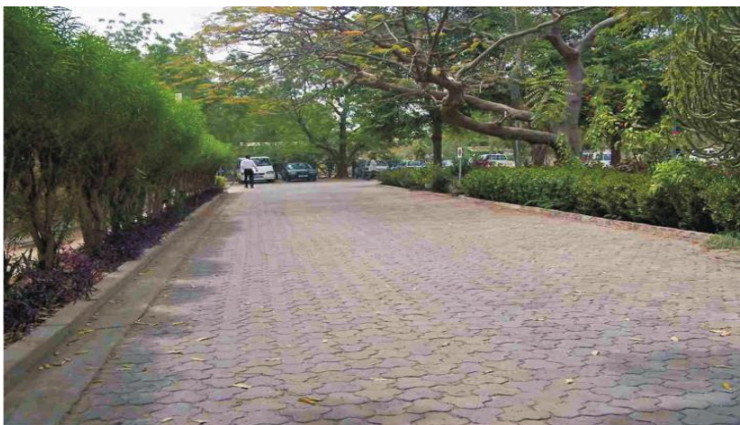
Figure 4 : Une allée pavée en plastique à Niamey au Niger (ProGeCo/ReCoMaPFiche n°11 p10)
